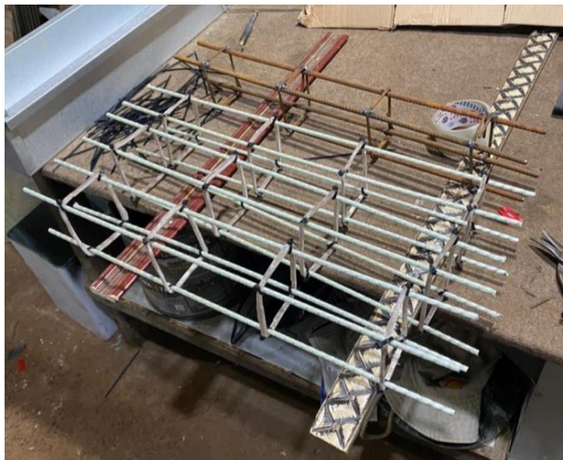
FIGURA 14 - Preparo das armaduras de GFRP, uso de abraçadeira Nylon para fixação dos Estribos (Fonte: Autor, 2023)
