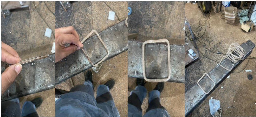
FIGURA 13 - Execução dos Estribos em GFRP (Fonte: Autor, 2023)
