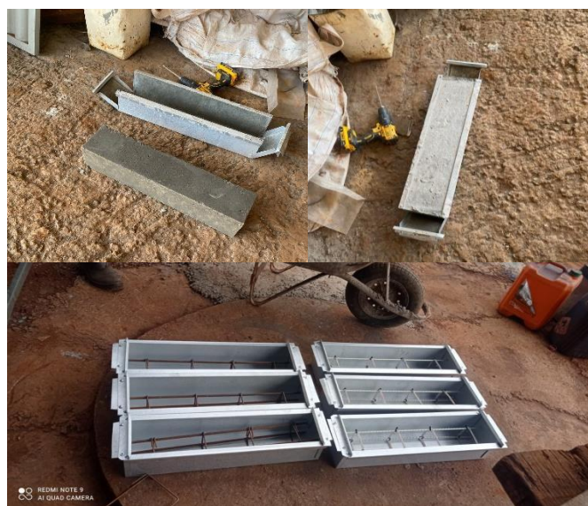
FIGURA 18 - Desmoldando / armaduras prontas para concretagem (Fonte: Autor, 2023)
