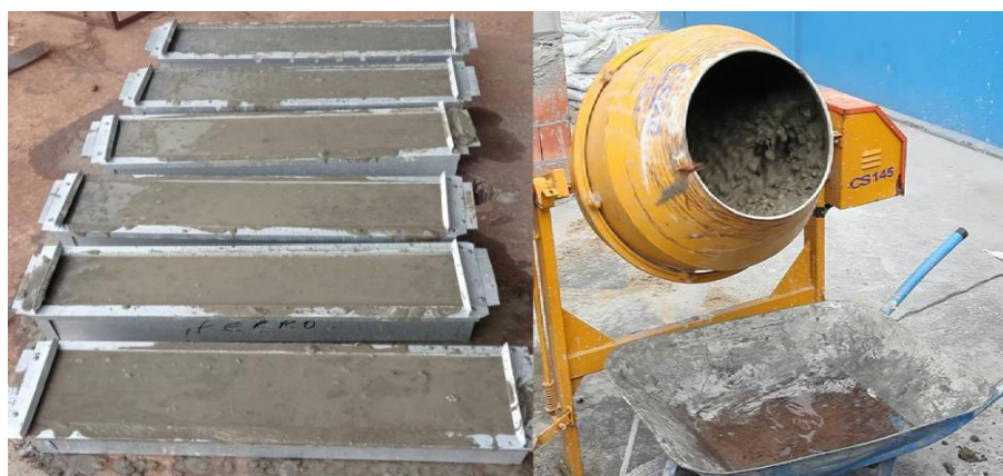
FIGURA 15 - Preparo da dosagem do concreto C25 (Fonte: Autor, 2023)
