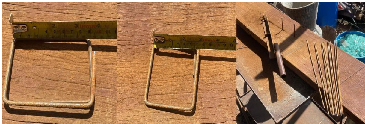
FIGURA 10 - Execução dos Estribos em aço (Fonte: Autor, 2023)
